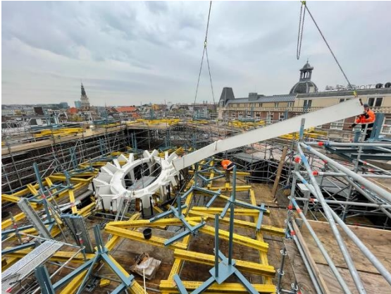
Foto: de eerste 'poot' wordt aangevoerd vanaf het midden van de atriumkap.
