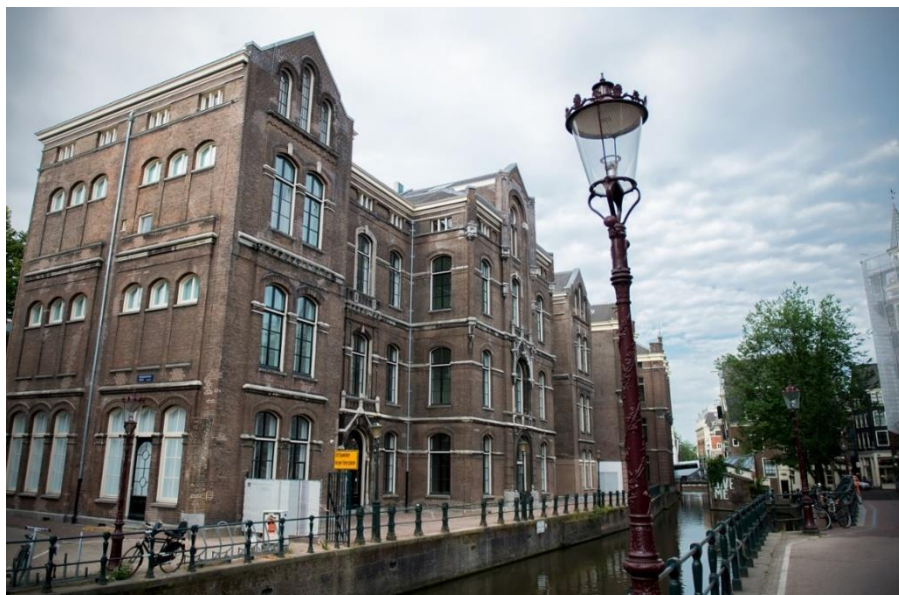
Figuur 12: Gebouw BG2
