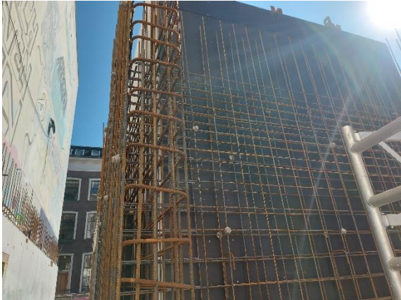
1: Wapening t.b.v. de betonwanden
