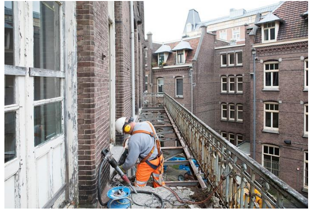
4: Demontage van het balkon
