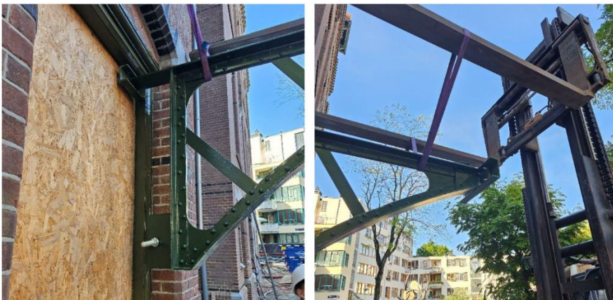
5: Proefmodel van het herstelde balkon
