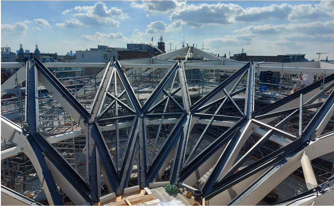
6: De Atriumkap met de gemonteerde goten.
